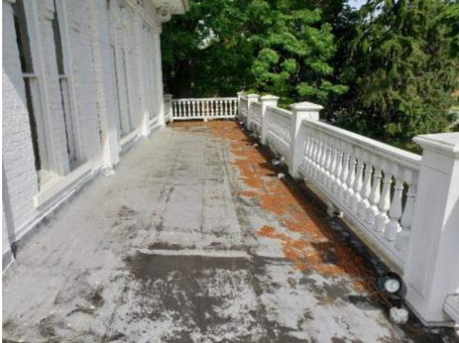
Porch roof, raise electrical conduit
